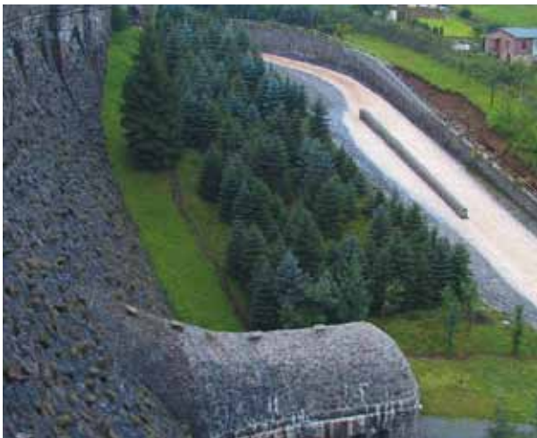
Talsperre mit Hochwasserentlastung
