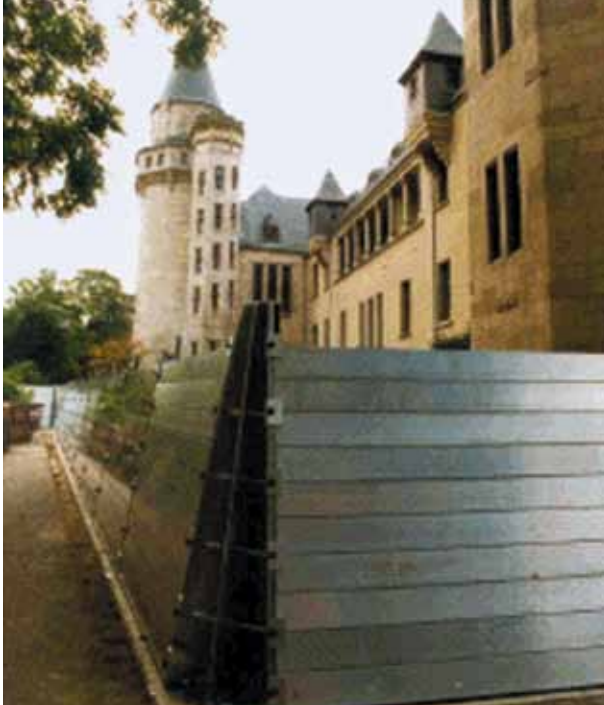
Mobiler Hochwasserschutz mit Dambalken
