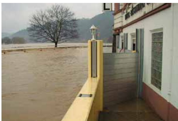
Umlaufender Hochwasserschutz mit teilmobile Schutzelementen
