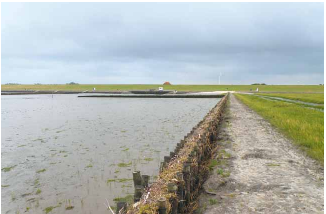
Küstenschutz mit Lahnungen und Hochwasserschutzdeich
