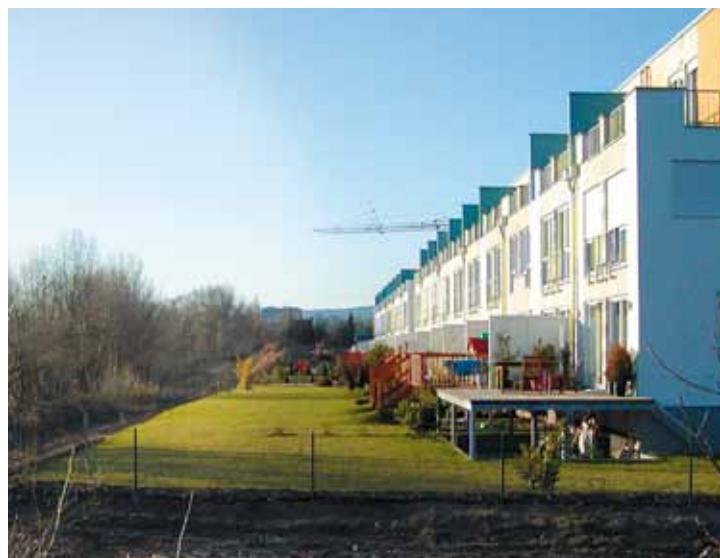
Hochwasser angepasste Bauweise mit erhöhtem Erdgeschoss
