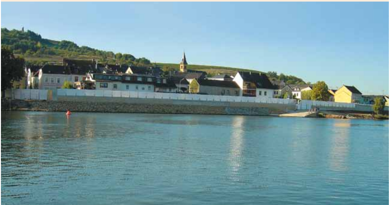
Hochwasserschutz in Oberbillig an der Mosel
